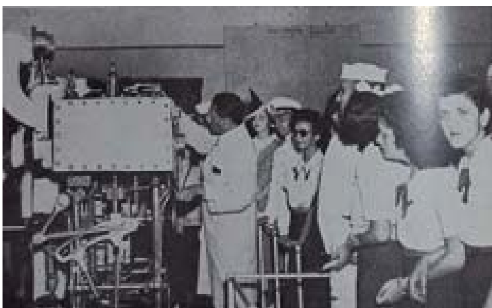
Figura 12: Gabinete de Máquinas.
